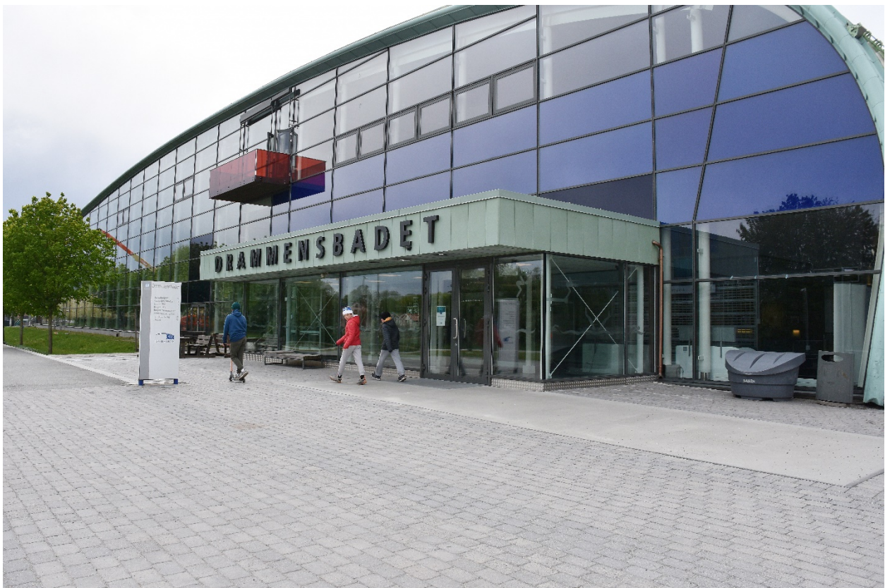
Drammensbadet – nytt inngangsparti
