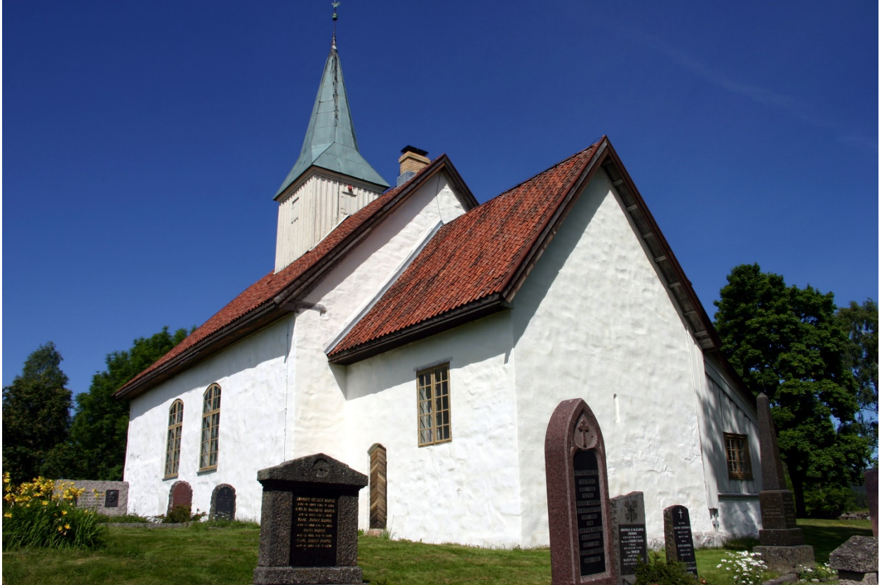
Skoger gamle kirke rehabiliteres
