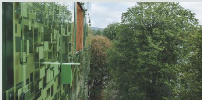
Fuglekasse integrert i fasaden, Døleinggata 9, Oslo / Element
