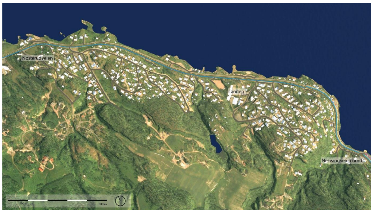
Figur 61: Alternativ 1 - delstrekning 3b. Dagens løsning for gående og syklende (GS-vei på vestsiden og østsiden av Svelvikveien mellom Nøsterudveien og Nesvangveien nord), beholdes uendret.
