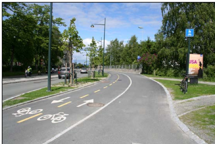
Figur 11 Eksempel på tovegs sykkelveg med fortau i Trondheim (Foto: Tom André Alstadsæther)
