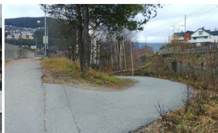
Vegen tar svingen under broa
