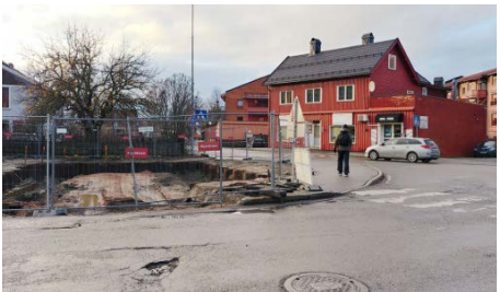
Hjørnet mellom Drammensveien og Hagatjernveien
