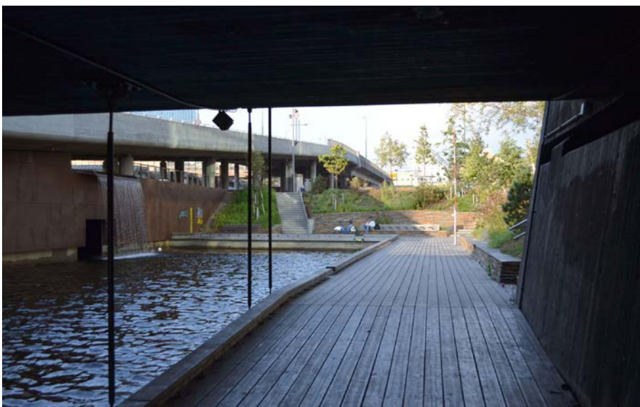
Figur 2: gangveg opphengt over vannet. Akerselva, Oslo.
