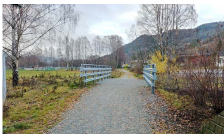
Bro over Mjøndalsbekken
