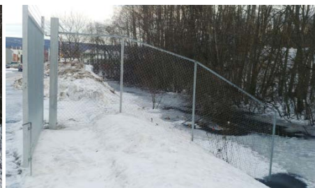
Strekningen forbi Biltema er inngjerdet, gjerdet strekker seg helt ned til vannet
