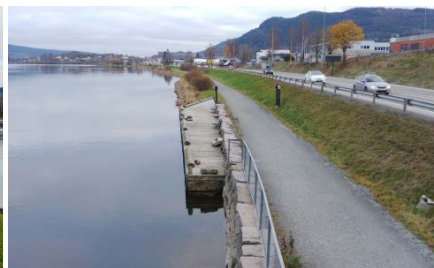
Fra Mjøndalsbrua østover
