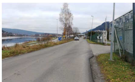
Strandveien retning østover
