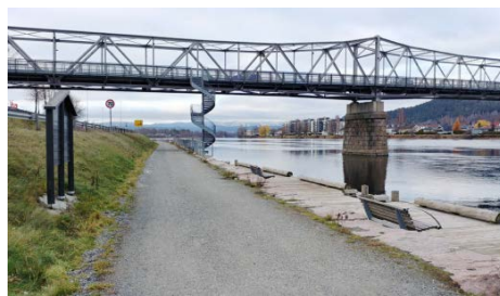
Vindeltrapp mellom broa og GS-vegen
