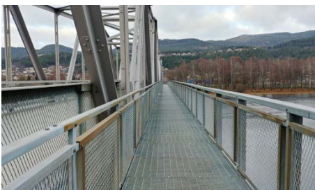
Anlegg for myke trafikanter i Mjøndalsbrua
