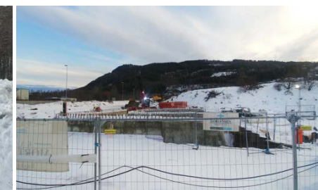
I enden av strekningen mot E 134 bygges en ny pumpestasjon
