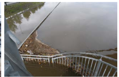
De nederste trinnene og GS-vegen under flomhendelsen i 2015
