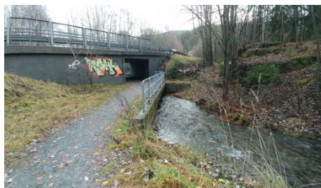
Undergang under Orkidehøgda
