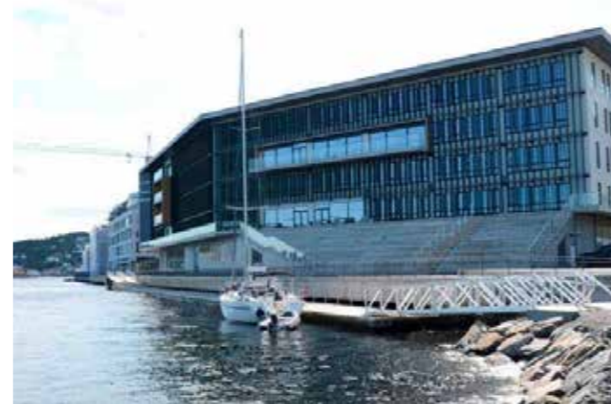
Havnegården i Arendal, betong flytebrygge med landgang
