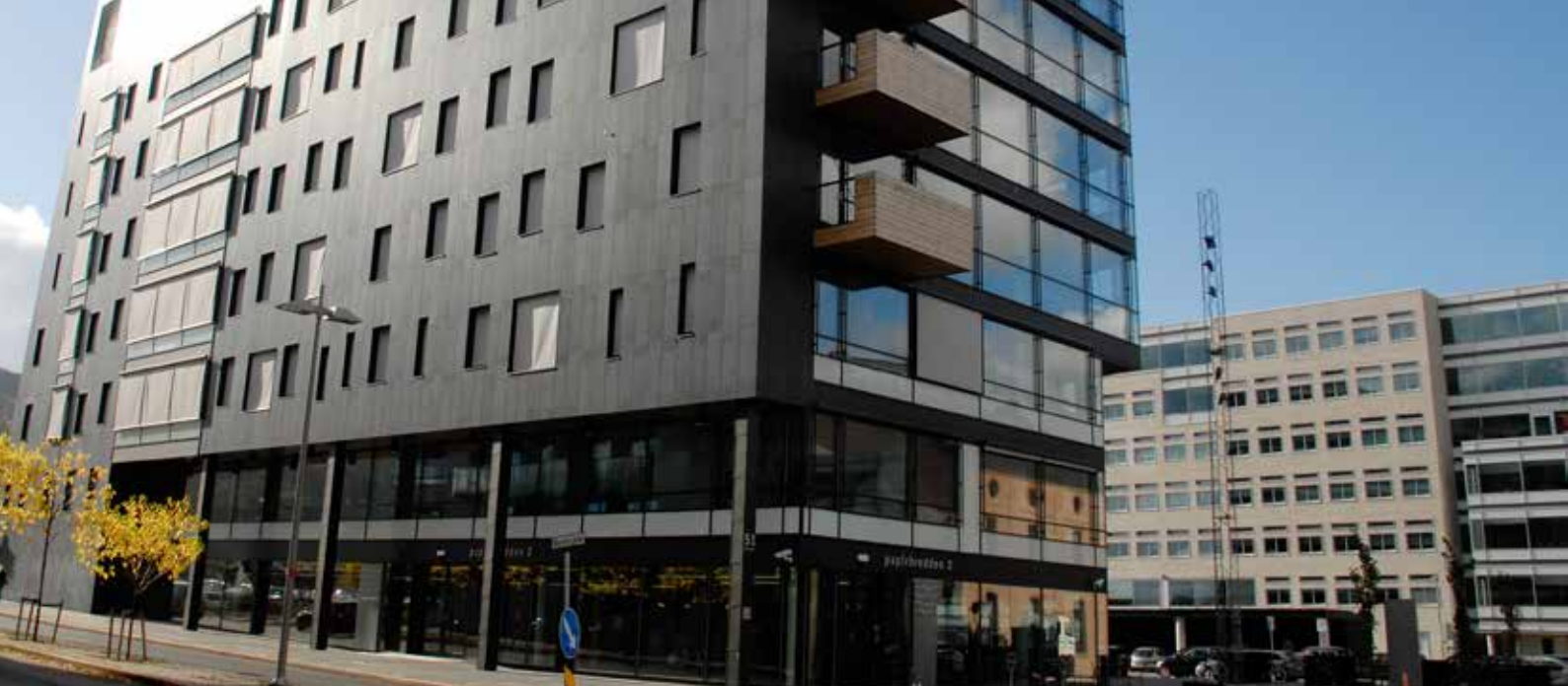
Papirbredden 2 – hus 1 vant Drammen bys byggeskikkpris i 2013.
