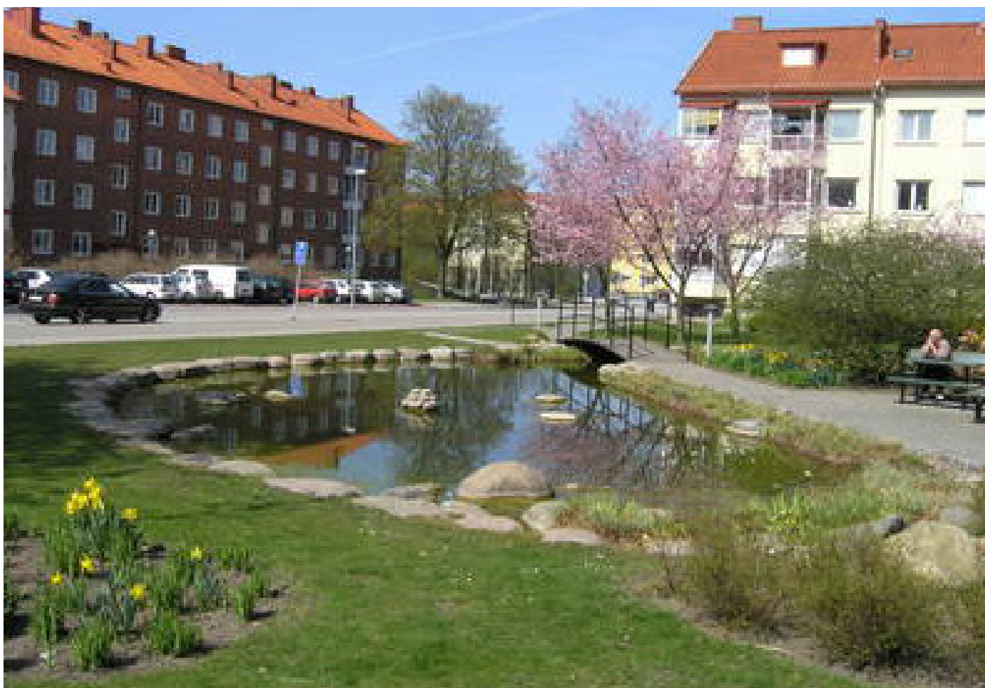
Åpen overvannshåndtering i Augustenborg i Malmø, Sverige. Foto: Ole Billing Hansen
