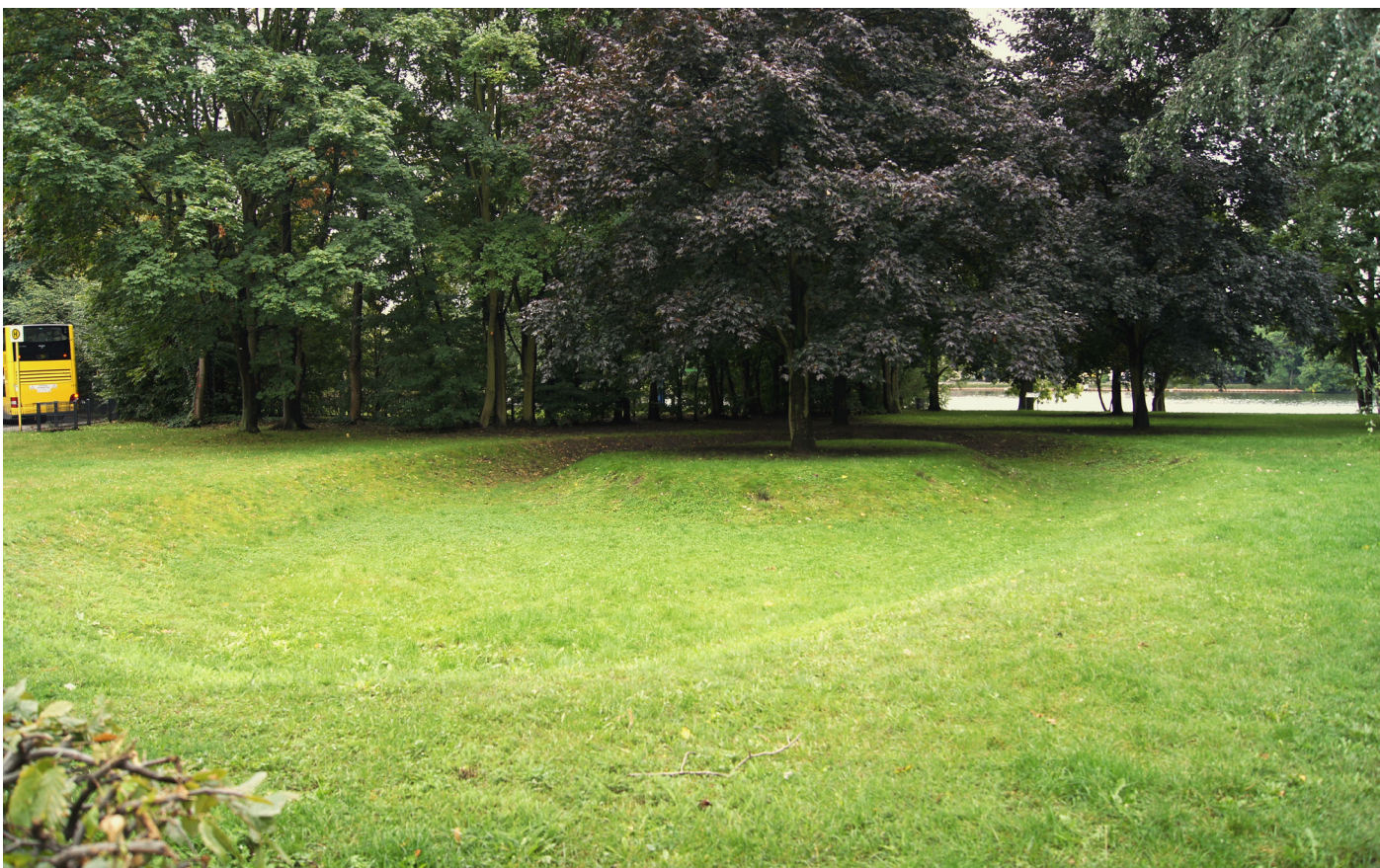
Areal i parkområde i Berlin (Tyskland) benyttet til tørr fordrøyning og kontrollert oversvømmelse. Foto: Marianne Dahl
