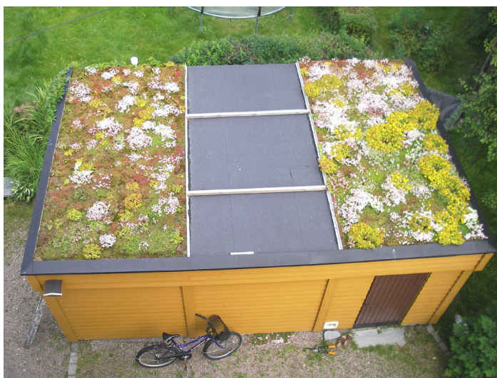
Grønt vs. tradisjonelt tak på fotografens garasje i Norge. Taket brukes til forsøk med vegetasjon, noe som har vist at ca. 25% av nedbøren holdes tilbake på dette grønne taket. Foto: Bent Braskerud
