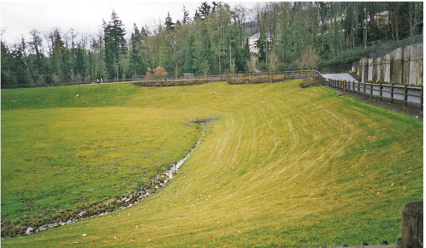
Parkmessig opparbeidet område benyttet til kontrollert oversvømmelse og fordrøyning i Lakemont Park (USA). Foto: Tillatelse gitt av Svein Ole Åstebøl
