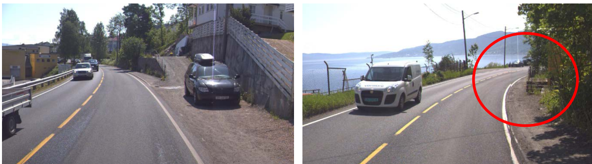
Figur 12 Bildet til venstre – parkert kjøretøy medfører at mye trafikanter blir «presset» nærmere vegbanen Bildet til høyre – meget smalt fortau forbi trappen, ca. 0,8-1,0 meter (Kilde: NVDB 123)
