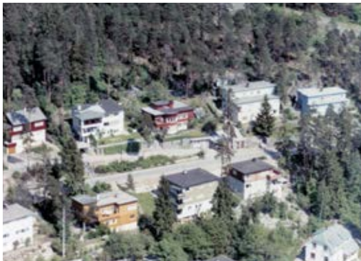
D2-100 Deler av kulturmiljøet med funkisvillaer i Hans Hansens vei, fotografert i 1960. Det gule huset er Hans Hansens vei 15
