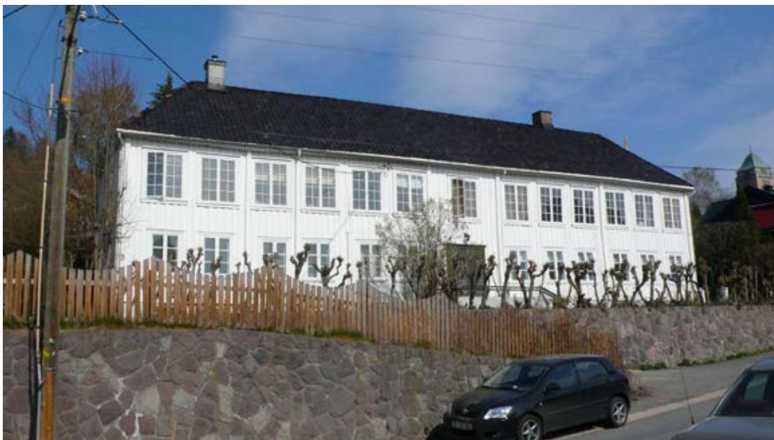
D2-87 Sommerfryd i Bergstien 65, lystgård oppført for Johan Gottfried Schwencke i år 1800. Bygningen er vedtaksfredet
