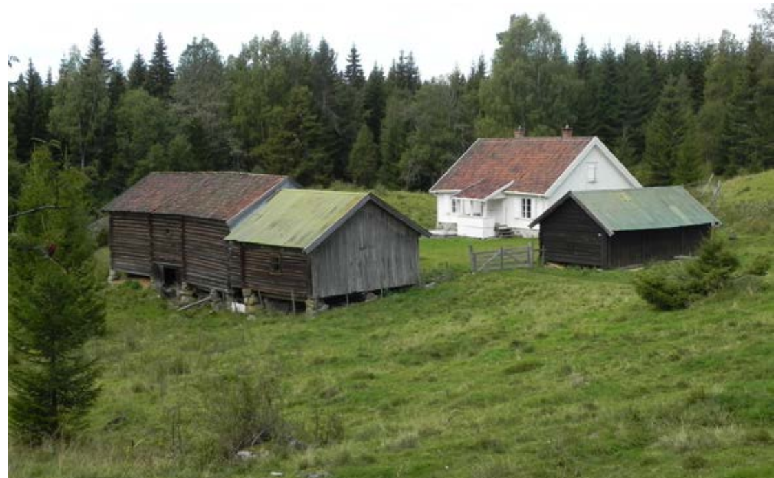
D3-6 Skulkerud gård på Konnerud. Gården er registrert som kulturmiljø, og har en godt bevart empirebygning som våningshus. Gården består i tillegg av låve, smie, fjøs og bryggerhus
