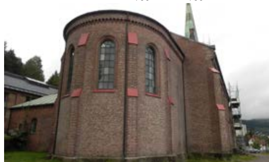
D2-20 Tangen kirke, bygget 1854. Arkitekt H.E. Schirmer
