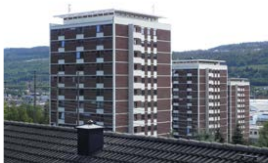
D2-104 Åshøgda borettslag
