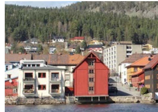
D2-80 Øvre Sund 8. Sjøboden er nå ombygd til boliger
