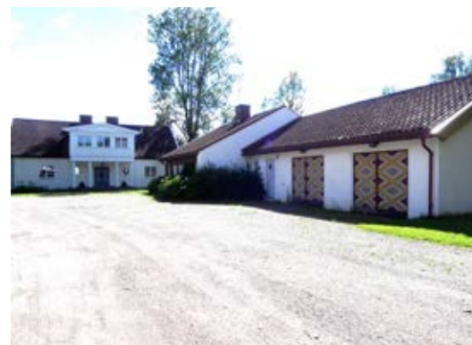
D2-37 Imhjelt Nordre. Bolighuset tegnet av Eindrude Slåtto i 1955 og drengestua ombygd på samme tid etter tegninger av Slåtto
