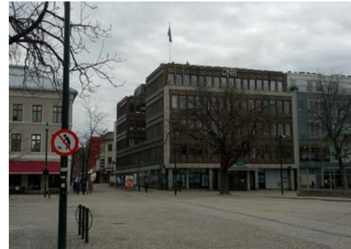
D2-53 Bragernes torg 11, forretningsgård oppført i 1970 for Drammen sparebank etter tegninger av arkitektkontoret Nilsen og Grenager
