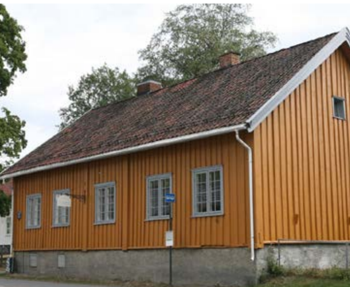
D1-11 Strømsfjerdingen skole, Nedre Eikervei 13, byens eldste skolehus. Eies av Drammen historielag, som benytter bygningen til forsamlingslokale og museum.
