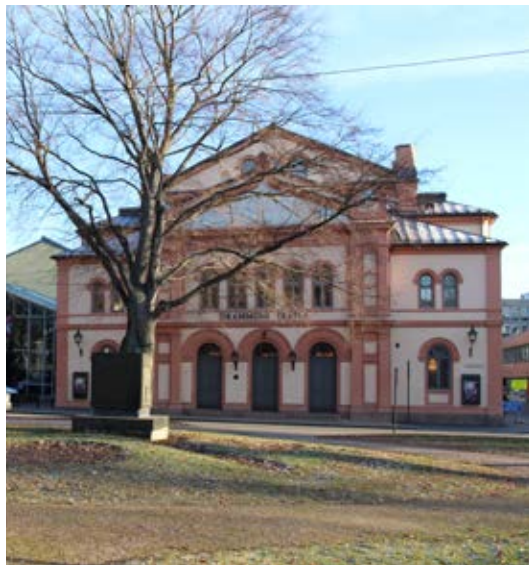
D1-14 Drammens teater er del av kulturmiljøet på Gamle Kirkeplass. Gjenoppbygget i 1997 som en tilnærmet kopi av teateret fra 1870, etter at det opprinnelige teateret ble totalt ødelagt i brann i 1993. Teateret var i sin tid tegnet av arkitekt Emil Victor Langlet.
