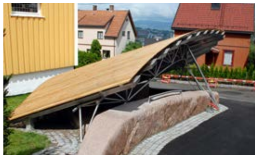
D1-7 Helleristningene i Skogliveien er overbygd med et spesialtilpasset vernebygg som tar vare på kulturminnene og samtidig sørger for at de er synlige og tilgjengelige.
