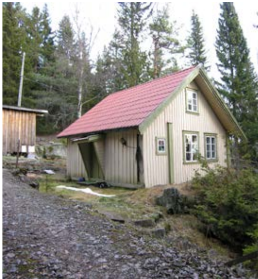
D2-27 Sophie Amalies vei 20. Et av meget få velbevarte hus fra den første bergverkstiden på Konnerud - i sitt opprinnelige miljø
