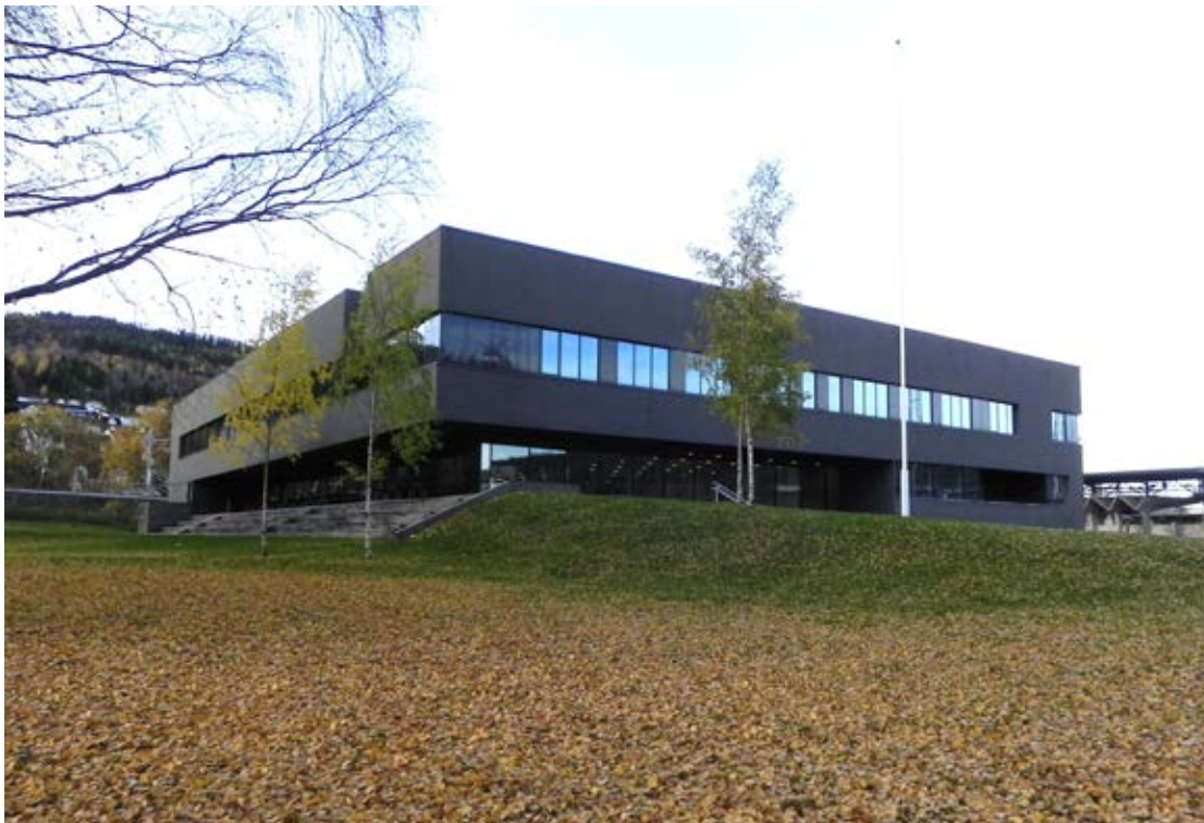
D2-18 Marienlyst skole. Oppført 2010, tegnet av div.A. arkitekter. Norges første skoleanlegg som tilfredsstillende passivhuskravene
