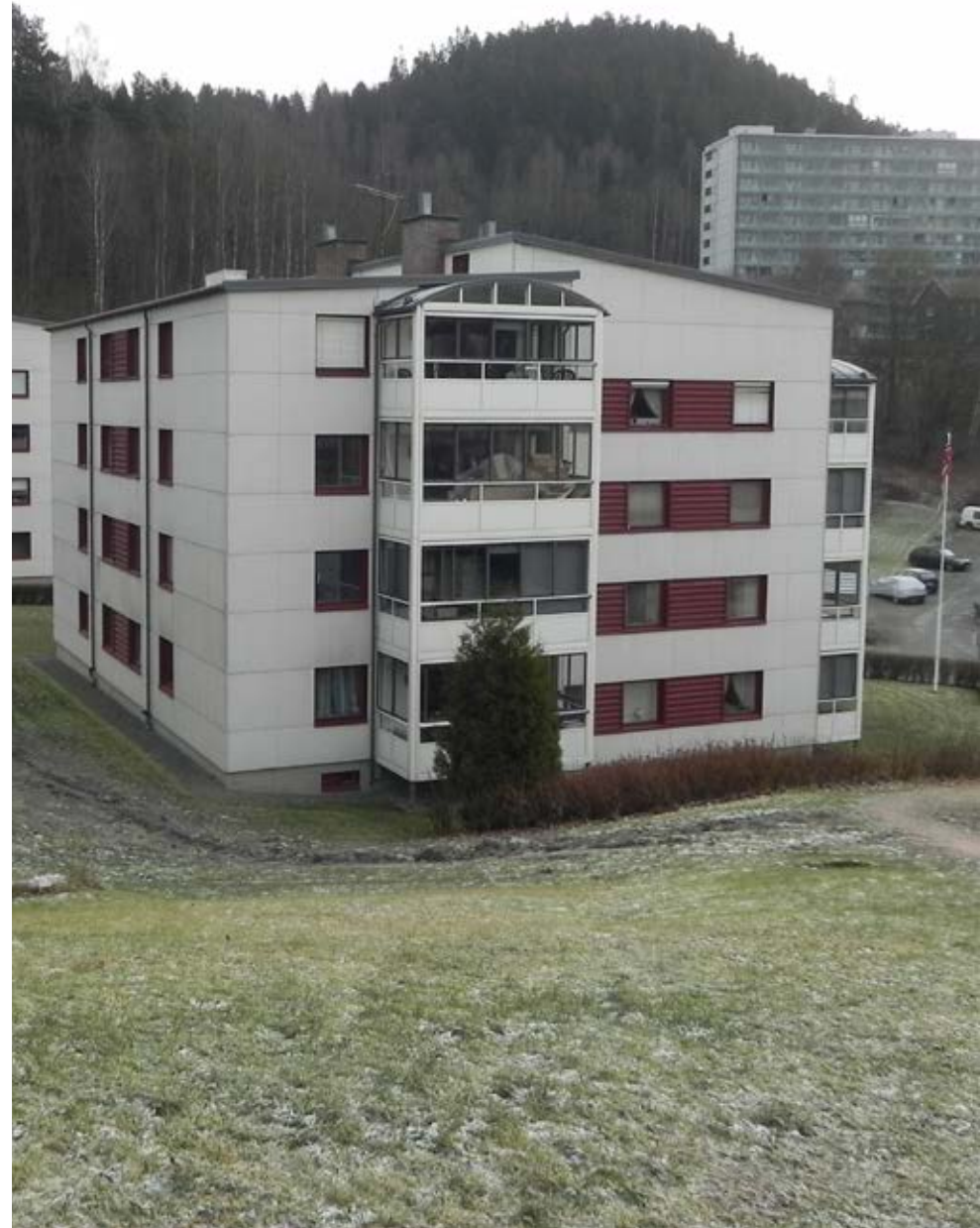
D2-110 Maria Feghts gate - Langbakken borettslag. Boligblokker utformet etter moderne prinsipper. Byggeår 1957
