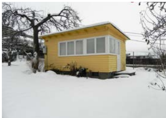
D2-68 Hytte 22 i Bragernes kolonihager. Hytta er bygget etter opprinnelige tegninger av Alf Bugge. Veranda senere innbygd
