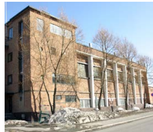
D2-50 Turnhallen, tegnet av byarkitekt Alf Bugge
