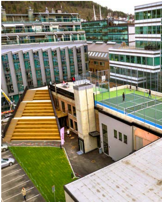
D1-12 Brodahl Gummivarefabrikk, Grønland 57, har fått ny bruk med blant annet kontorer, bar, butikker og uteoppholdsarealer på taket.
