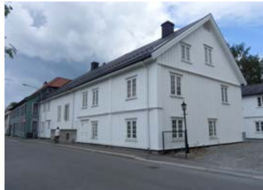
D2-91 Simersgården, Landfalløya 50, fra 1700-tallet. Gatefasaden ble rekonstruert i 2010. Gården har også drengestue og sidebygning.
