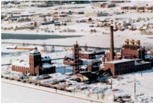
D2-44 Gulskogen Cellulosefabrikk i 1968. Tårnbygningen til venstre og den lave murbygningen bak til høyre er kulturminner med høy verdi
