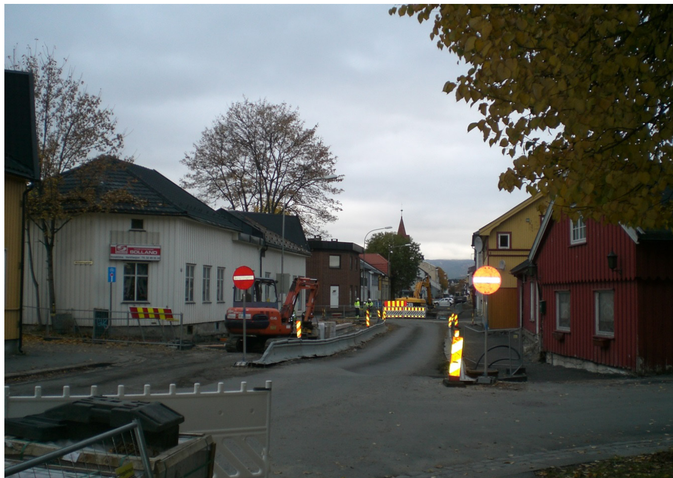
Bebyggelse fra slutten av 1800-tallet langs Tordenskiolds gate (nr 116-102). Nr 103 på høyre side samt nr 105 fra 1600-tallet mot Bromannsgangen (NIKU 2013)
