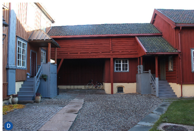
Bakgårdsbebyggelse i Cappelengården (NIKU 2013)
