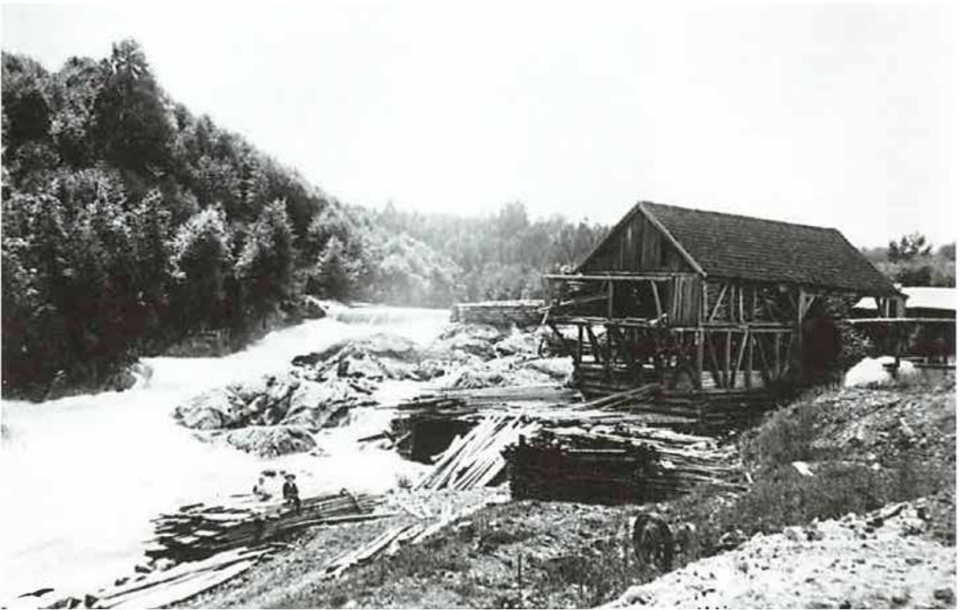
Vannsagene preget Eiker i mer enn 350 år, før dampsager og treforedlingsindustri overtok. Ved begynnelsen av 1900-tallet sto det fremdeles slike sager mange steder på Eiker. Her ser vi Verkens foss, sag i Skotselv, Øvre Eiker. (Øvre Eiker bibliotek)
