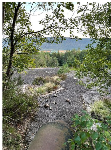
Eksisterende stikkrenne under 800-meteren
