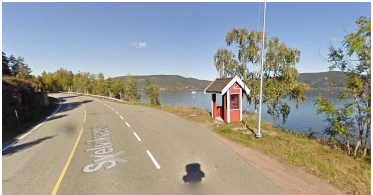
Nordgående bussholdeplass (google streetview)
