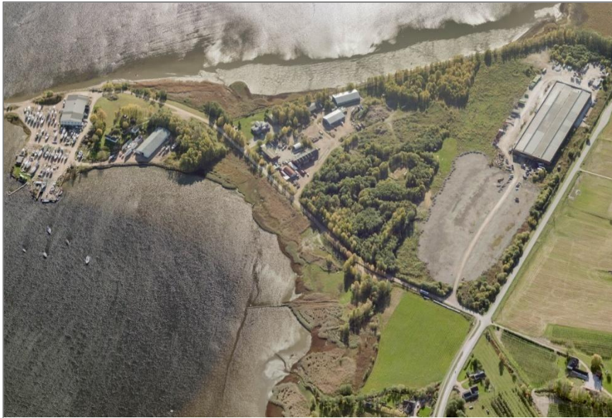
Figur 1 Skråfoto tatt mot sør. Kilde: 1881.no
