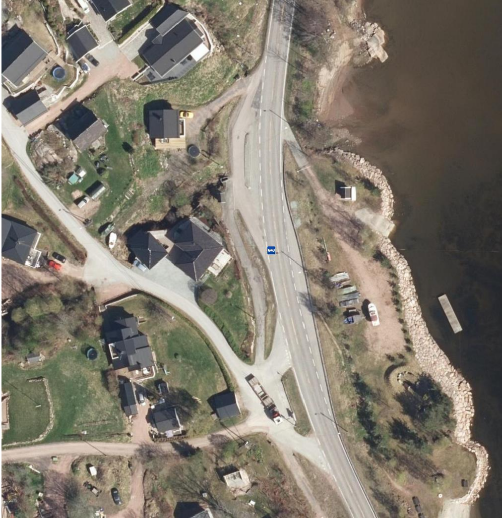
Kryssutforming og manglende fotgjengerkryssing ved Hella. (Foto: Googlemaps)
