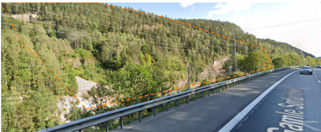
Figur 6: Eiendommen sett fra Gamle Sørlandske (E18)
