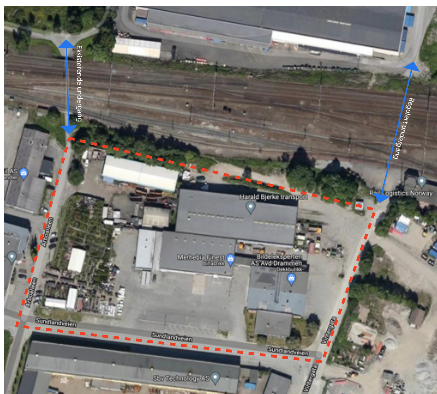
Flyfoto av eiendommene som viser dagens og fremtidig undergang. Kilde: google.no/maps
