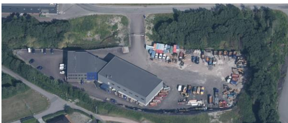
Figur 20. Næringsseierdom for plasskrevende varer, med eget anlegg for adkomst, parkering og lagringsareal. Næringsseierdommen er adskilt fra tilgrensende eiendommer med et grøntområde, hentet fra Dråpen 6 (kilde: 1881).
