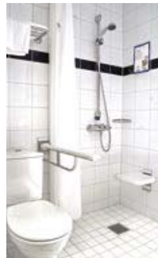
Tilgjengelig badrom. Bør også være støttehåndtak i dusjhjørnet.
