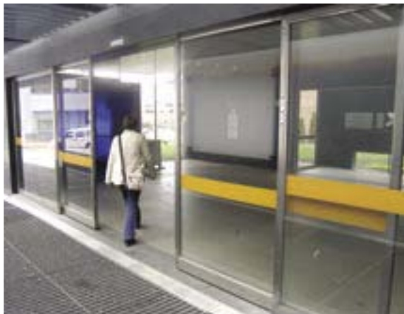
T-banestasjon med markering av glassfelt i skyvedør.
