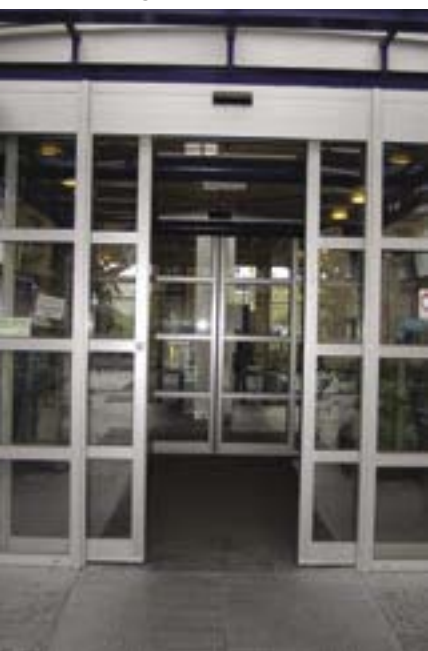
Trinnfri inngang. Doble skyvedører gir stabil innetemperatur.
