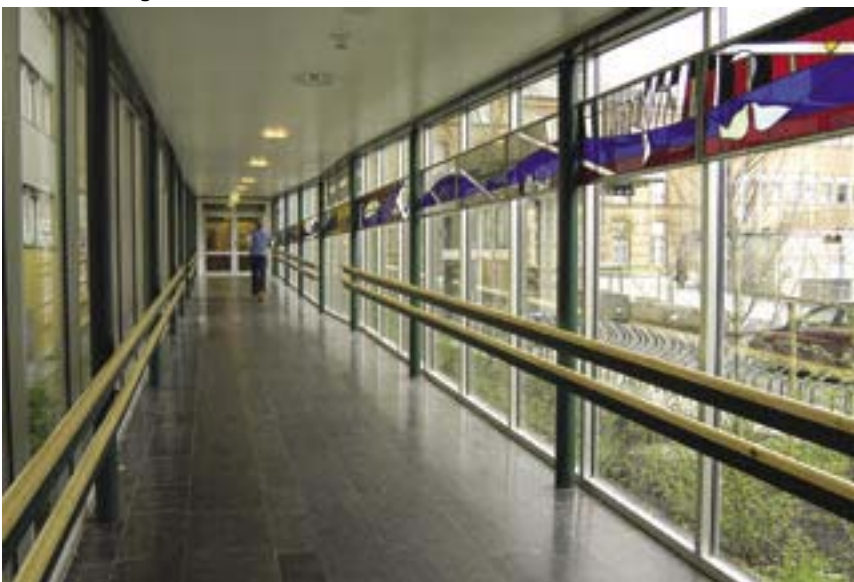
Rampe forbinder gammelt og nytt bygg. Hvilerepos og rekkverk i to høyder.
