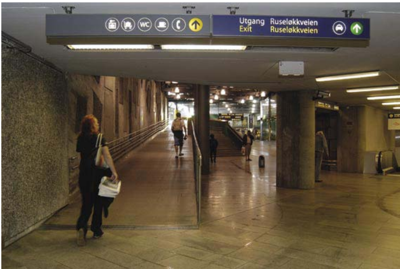
Togstasjon. Trinnfri innvendig kommunikasjonsvei. Heis i tillegg. Tydelig skilting, men mangler kontraster mellom gulv, vegg og søyler.
