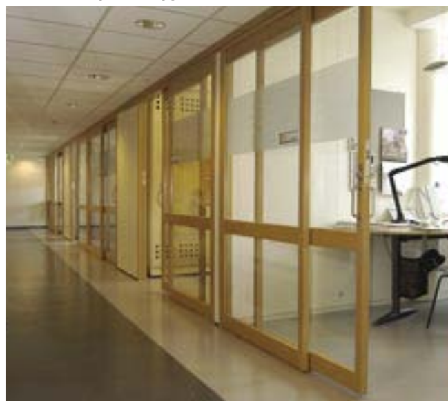
Tilgjengelige kontorer med skyvedører, trinnfritt og med kontraster i gulvbelegg.
