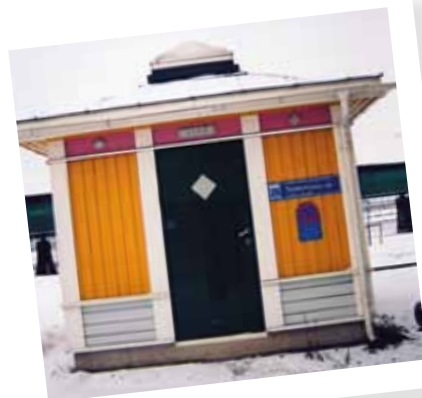
Et av byens mange pumpehus.
