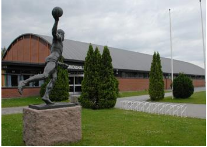
Drammenshallen. Foto: Birgitte Simensen Berg
