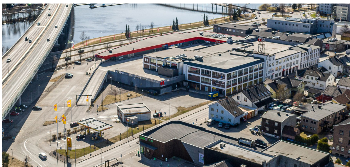
Figur 4: Dronebilde av eksisterende bebyggelse sett mot sør-vest.
