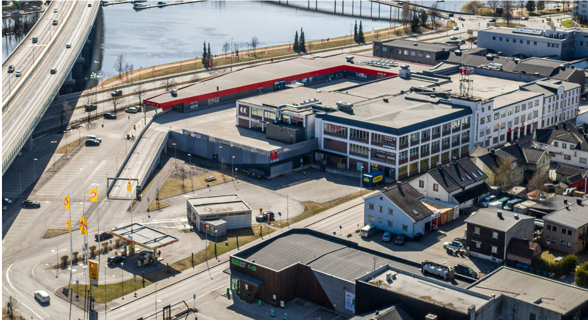
Figur 6: Dronebilde av eksisterende bebyggelse sett mot sør-vest.
