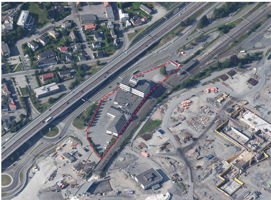
Figur 3: Skråfoto av tomta med nærmeste omgivelser. Skråfotoet viser eksisterende bebyggelse, og at planområdet ellers i hovedsak består av asfaltert parkeringsplass. Siden skråfotoet ble tatt, har utbyggingen av sykehuset og helseparken (til høyre i bildet) kommet lengre.
